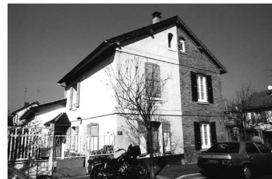
Εικ.2: Οικισμός εργατών της σοκολατοποιίας Menier, Noisiel, Γαλλία (φωτό Β.Πετρίδου 2005)
