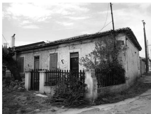
Εικ.2: Εργατικές κατοικίες στον οικισμό Κυπριανού σε φωτογραφία του 2009.
