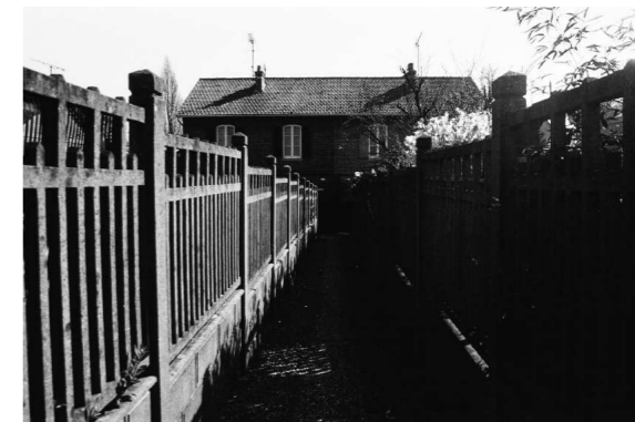
Εικ. 5: Οικισμός εργατών της σοκολατοποιίας Menier, Noisiel, Γαλλία (φωτό Β.Πετρίδου 2005)
